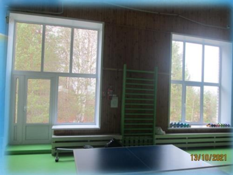
Замена деревянных оконных блоков на стеклопакеты в Чушевицком ФОКе
