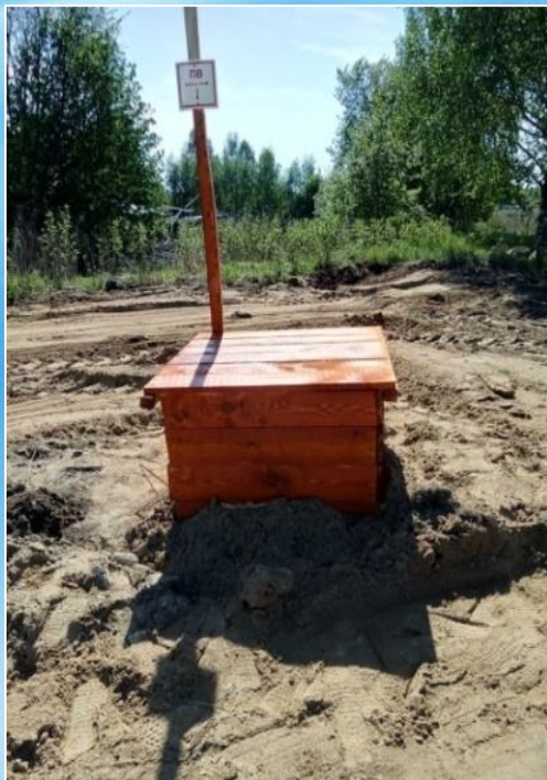
Строительство пожарного водоема в д.Ексинское
