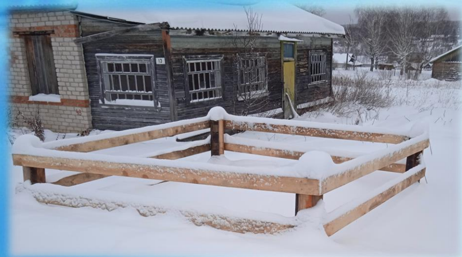
Обустройство пожарного водоема п.Пежда
