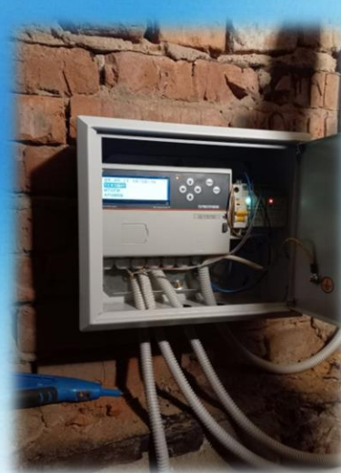
Установка прибора учета тепловой энергии в Чушевицком ДК
