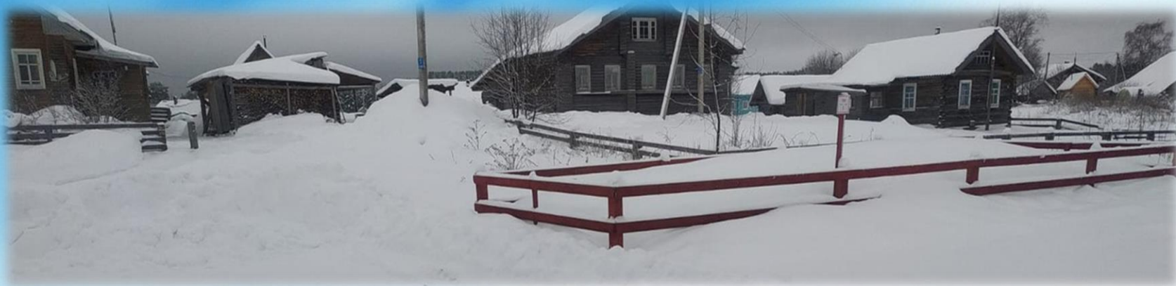
Строительство пожарного водоема д.Дьяконовская
