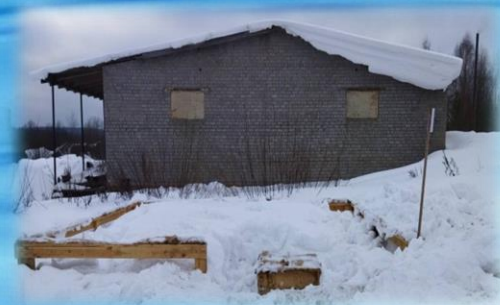
Обустройство пожарного водоема по ул. Прибрежная
