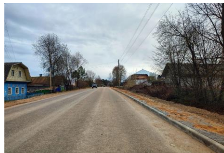
Благоустройство пешеходной зоны ул. Смидовича с. Верховажье
