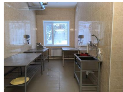
капитальный ремонт пищеблока БУЗ ВО «Верховажская ЦРБ»
