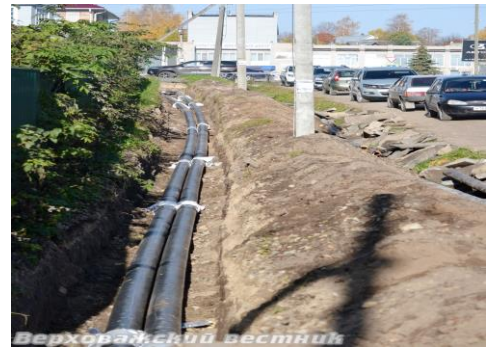
Замена магистральной теплотрассы в с. Верховажье
