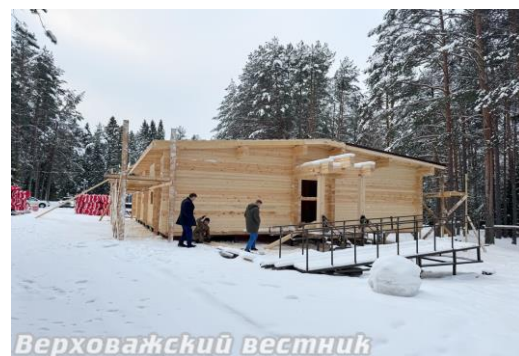
Строительство нового спального корпуса детского лагеря «Дружба»
